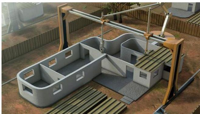
«Контурное строительство» (англ. Contour Crafting) — инновационная технология в строительстве, позволяющая без ущерба для эксплуатационных качеств конечной продукции автоматизировать самый трудоемкий
